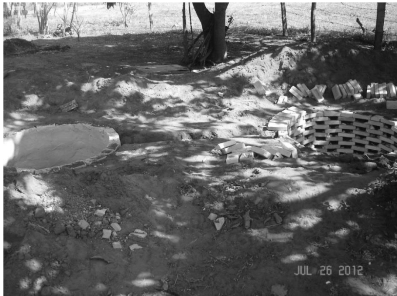
Foto 05: Fossa séptica em construção.
