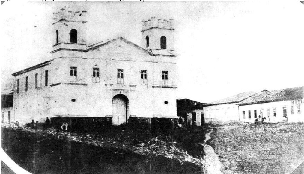
Figura 12 - Igreja de 1866, com o rego d’água na frente.
