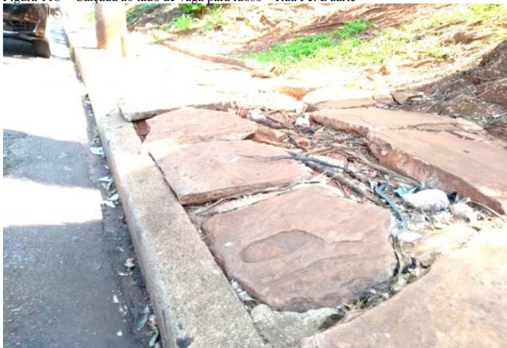
Figura 118 - Calçada ao lado de vaga para idoso – Rua Pe. Duarte
