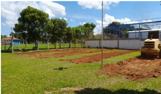
Figura 33 - Área durante a limpeza para a implantação do Projeto Arborização na UE 2
