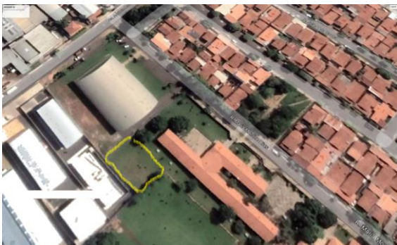
Figura 29 - Local escolhido destacado em amarelo para a implantação do Projeto Arborização na UE 02.
