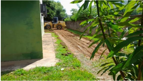
Figura 31 - Área durante a limpeza para a implantação do Projeto Arborização na UE 1.
