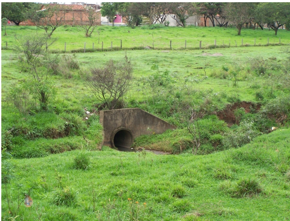
Figura 27 Exemplo de galeria pluvial no córrego Ponte Alta. Fonte próprio autor, 2011.
