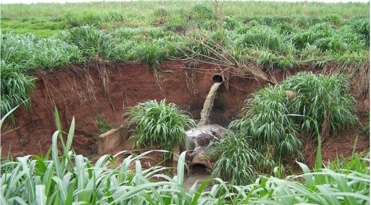
Figura 32 Lançamento de esgoto in natura, diretamente no córrego Maria Mendes (Ponte Alta). Fonte: próprio autor, 2011.
