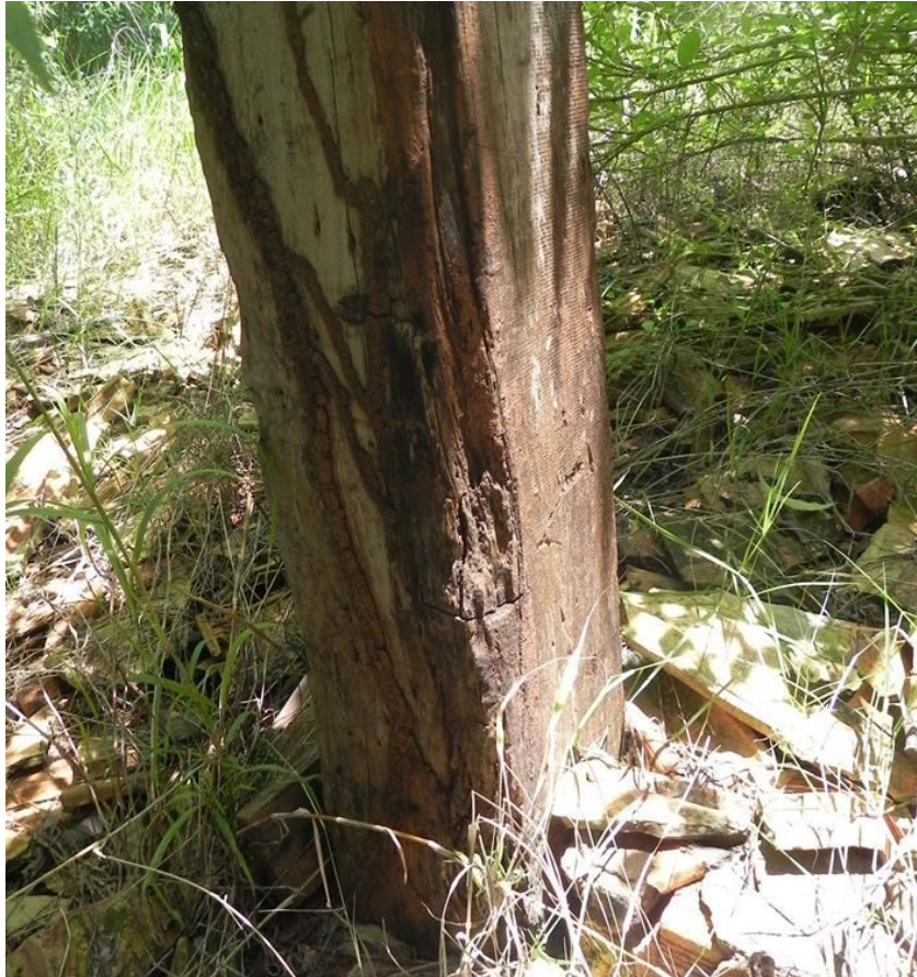
Figura 2 - Exemplo de pilar com ação de xilófagos. Fonte: Carolina Sato Pereira
