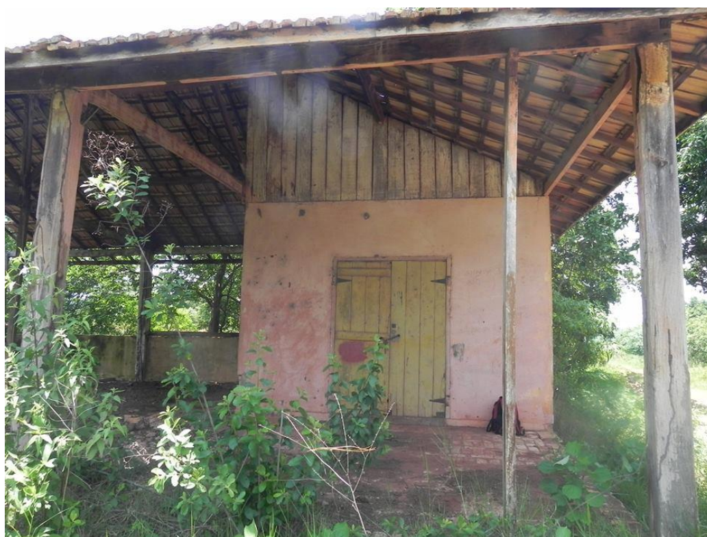
Figura 1 - Situação Atual do barracão
