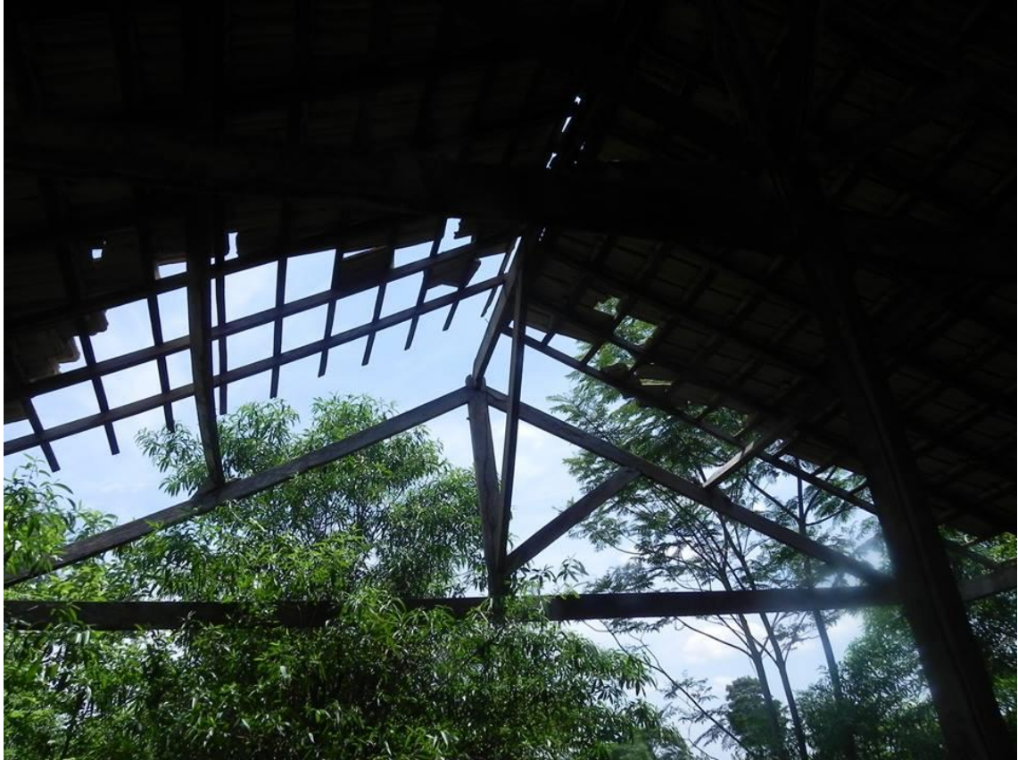
Figura 4 - Telhado da elevação sudoeste. Fonte: Carolina Sato Pereira
